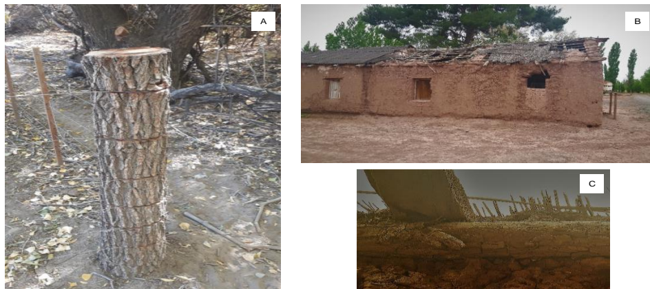
Figura N° 7 POSTE (A) Y PRIMER EDIFICIO DE LA ESCUELA PRIMARIA 14 (1925) (B) CON VIGAS DEL TECHO (C) CONSTRUIDOS CON Salix humboldtiana
