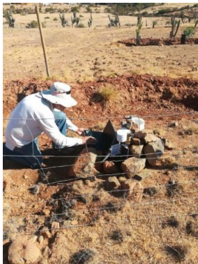
Figura N°4 INSTALACIÓN DE ESTACIÓN METEOROLÓGICA
