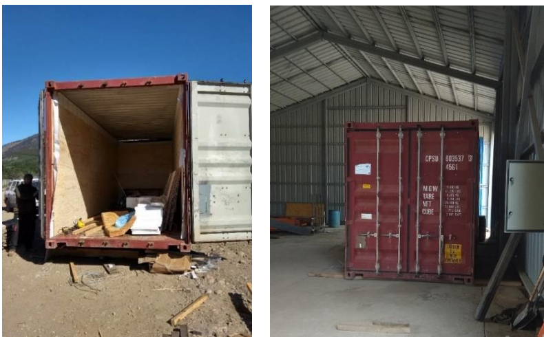
Figura N° 4 ARMADO DE CONTENEDORES CON CÁMARA DE SECADO PARA INSTALACIÓN DE EQUIPO DESHUMIDIFICADOR
