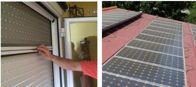
Figura N° 10 TERMOPANEL DE 3 CAPAS CON MOSQUITERO Y PERSIANA EXTERNA (IZQ) Y PANELES FOTOVOLTAICOS EN EL TECHO (DER)
