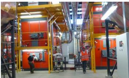
Figura N° 3 CALDERAS (IZQ) Y PISO MÓVIL (DER)
