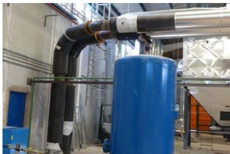
Figura N° 4 TUBERÍAS AISLADAS PARA CONDUCCIÓN DE AGUA SANITARIA (IZQ), PLAN MAESTRO DE DISTRIBUCIÓN DE CALOR (DER)
