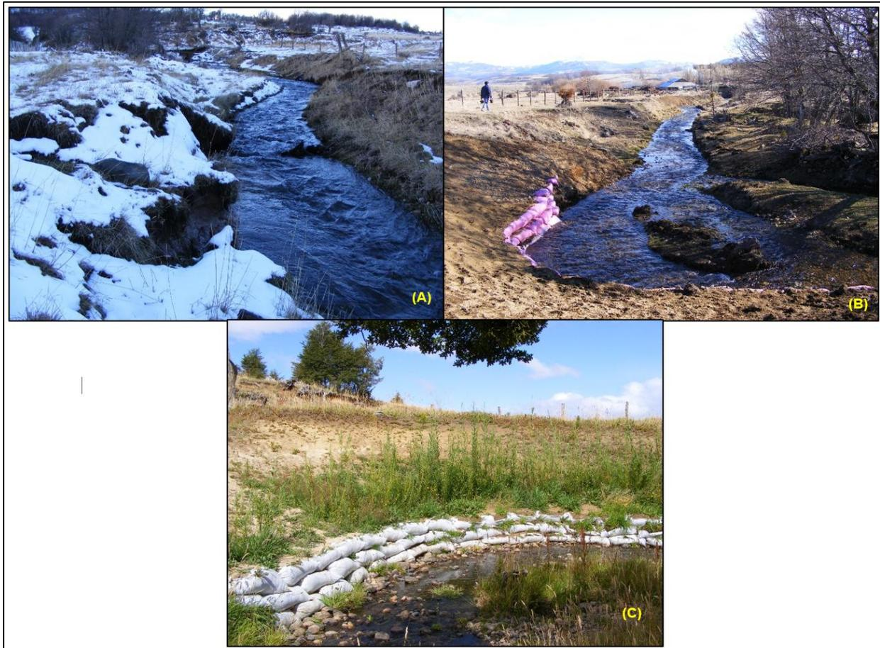
**Figura 5:** Estado de la ribera antes y durante el proceso de restauración: (A) Ribera degradada, sin intervenciones de restauración. (B) Ribera con mejoramiento de taludes de 45 grados y muros de sacos como parte del inicio del proceso de restauración. (C) Ribera con presencia de vegetación tras la restauración.
