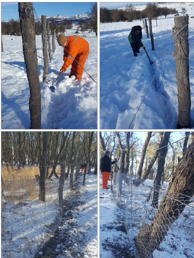
Figura N° 9 CONSTRUCCION DE CERCO PERIMETRAL
